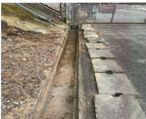
ภาพที่ 2-13 การขุดลอกตะกอนภายในรางระบายน้ำของโครงการ
