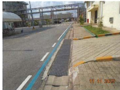
ภาพที่ 2-12 ระบบระบายน้ำภายในโครงการ
