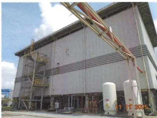
ภาพที่ 2-4 อาคารในลักษณะปิดคลุมแหล่งกำเนิดเสียง
